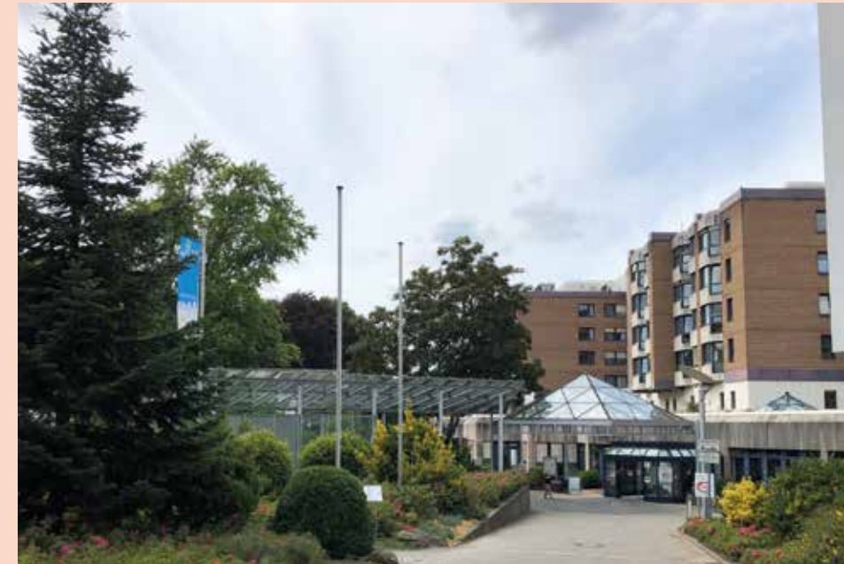
Noch ist der Haupteingang des Katharinen-Hospitals am Nordring. Nach der Fusion mit dem Evangelischen Krankenhaus zum Christlichen Klinikum Unna soll er nach umfangreichen Um- und Ausbaumaßnahmen an die Mozartstraße verlegt werden. Die Zufahrt zum Parkhaus erfolgt dann über den Verkehrsring – eine große Chance für die Verkehrsplanung in der Altstadt.
